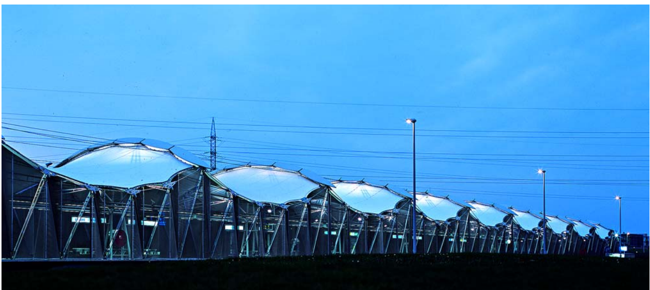
Het bespannen van de gevels met roestvast stalen weefsel maakt van het metrostation een open en gastvrije verschijning.
