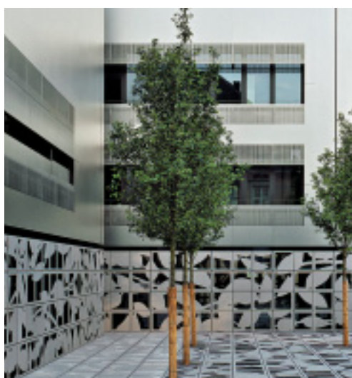
De elektriskt manövre- rade solskärmarna kan stängas så väl att de bildar ett rostfritt ytskikt utan synliga skarvar.
