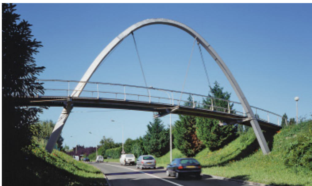
Brodäcket kröker under den rostfria bågen över en hårt trafikerad väg.
