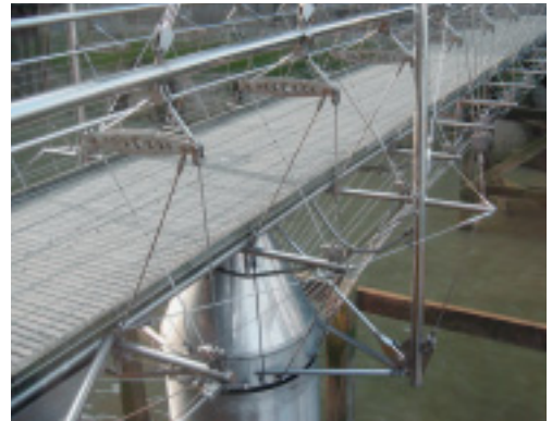
Ett solfjäderformat arrangemang av drags- tag bär den roterande gångbron.
