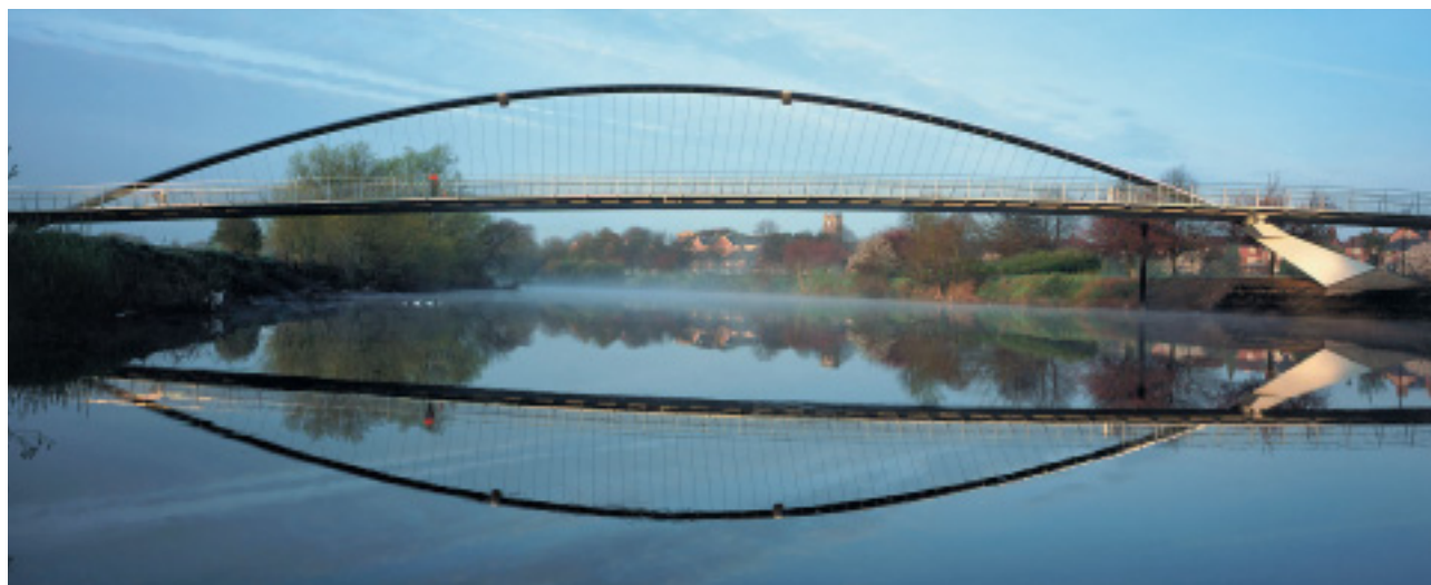
Den rostfria stålbågen, som spänner 80 m över floden, lutar 50^\circ från vertikalaxeln.
